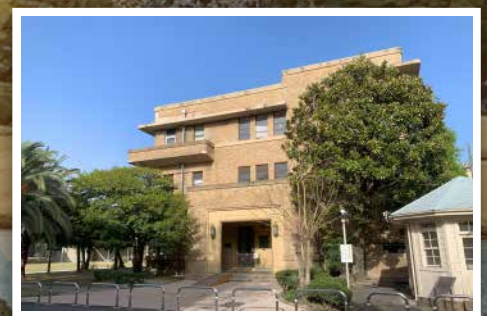
鹿田会館外観
